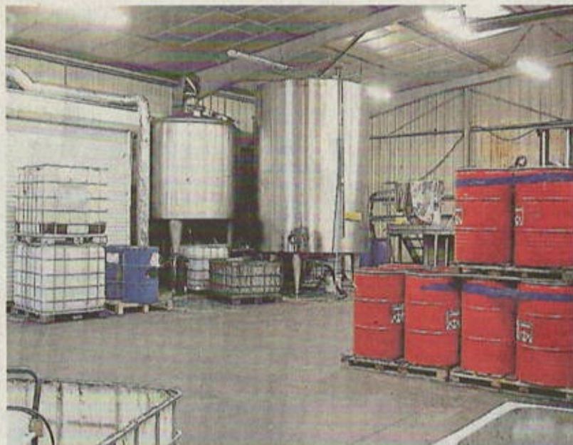
Chez Valoléique, on recycle les huiles alimentaires usagées pour fabriquer la matière première du biodiesel. À gauche sur la photo, le fondoir qui permet de liquéfier huiles et graisses.
